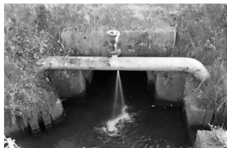
守山地区水管橋更新工事 該当箇所 漏水状況
