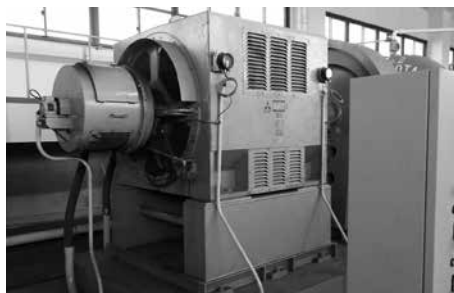
野洲川揚水機場電動機整備工事 該当箇所
